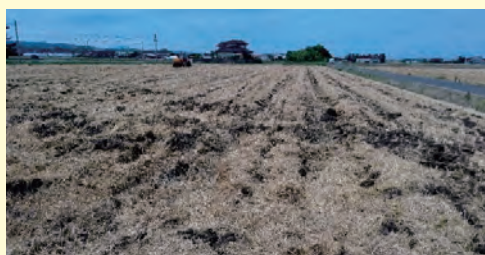
写真5 弾丸暗渠施工の跡、暗渠の幅は80cm
